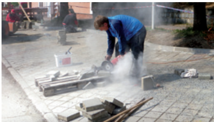
Dláždění parkoviště podél kostela a hřiště, ulice Dlouhá
