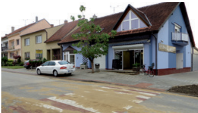
Ulice Dlouhá – nový vyvýšený přechod pro chodce před pekárnou
