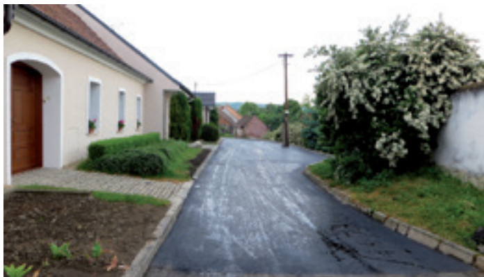
Ulice Horní – opravená vozovka rozšířená o podélná parkovací stání
