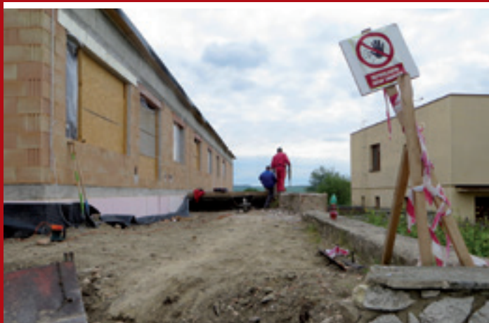
Přístavba Ekocentra Trkmanka, terénní úpravy a oprava obvodové zdi
