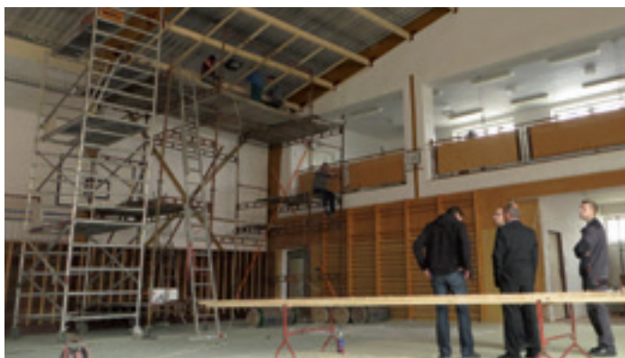
Generální oprava školní sportovní haly, snižování stropů a zateplování
